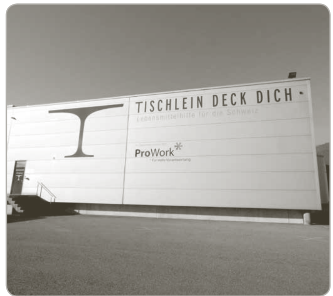
Die Fassade der neuen Plattform Mittelland frisch beschriftet.
