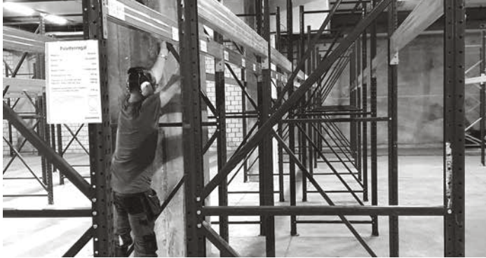
Winterthour: l'entrepôt pour palettes de la plateforme logistique Orientale est réaménagé – pour une utilisation optimale de l'espace qui était inoccupé jusqu'ici.
