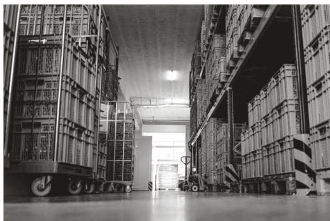
Une capacité de stockage plus importante et davantage de lumière à la plateforme logistique des Grisons à Coire.
