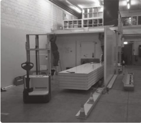
Nel mezzo dei lavori di ampliamento della Piattaforma della Svizzera Centrale.
