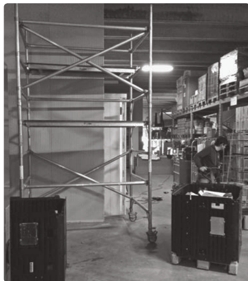
Der Ausbau der Plattform in Cadenazzo nimmt Form an.
